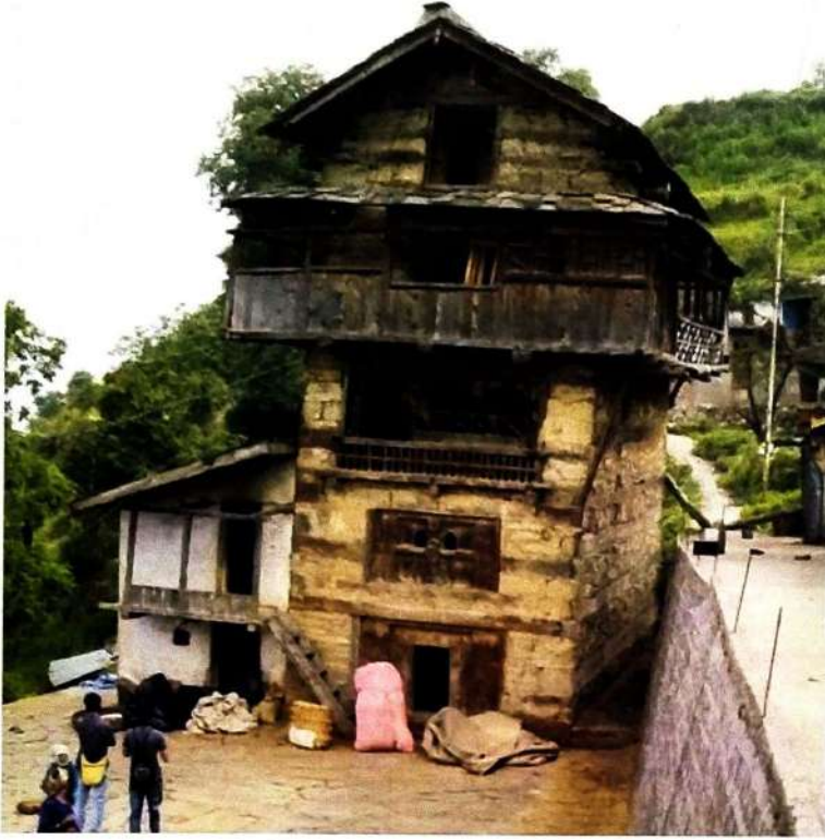
रैथल गाँव में कोटी बनाल शैली में बना भवन
