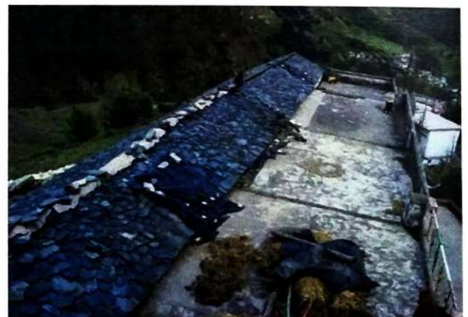
भवन की पुरानी पत्थर की दीवार के साथ जोड़ी गयी समतल आर.सी.सी. कंक्रीट की छत
